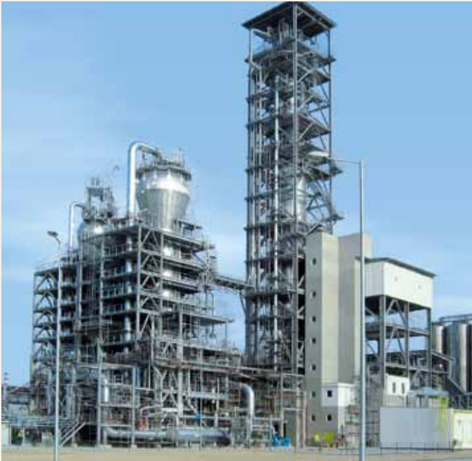
Polypropylenanlage in Bratislava
